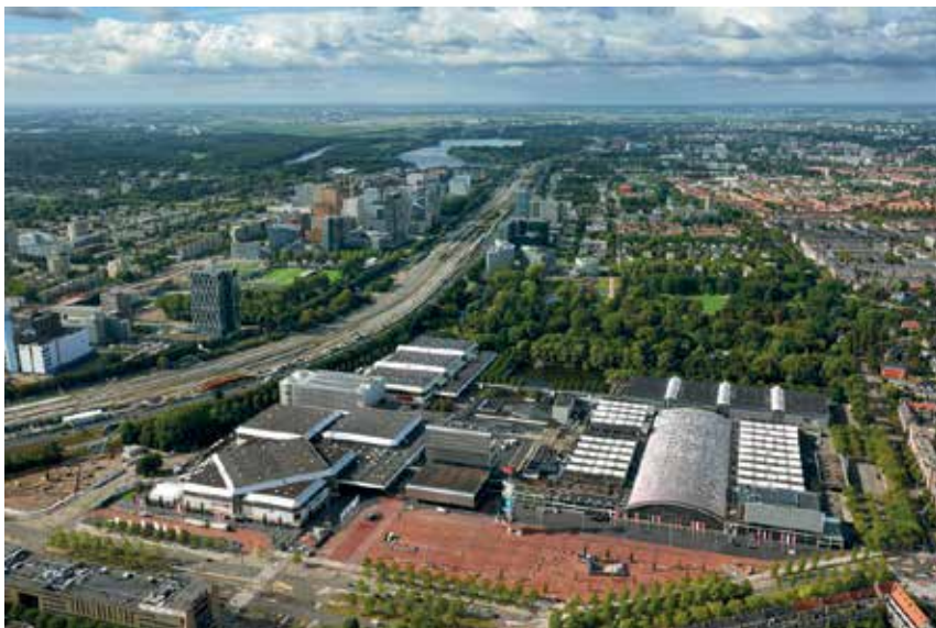
RAI Amsterdam vanuit de lucht. Links de bouwplaats van hotel nhow Amsterdam RAI
